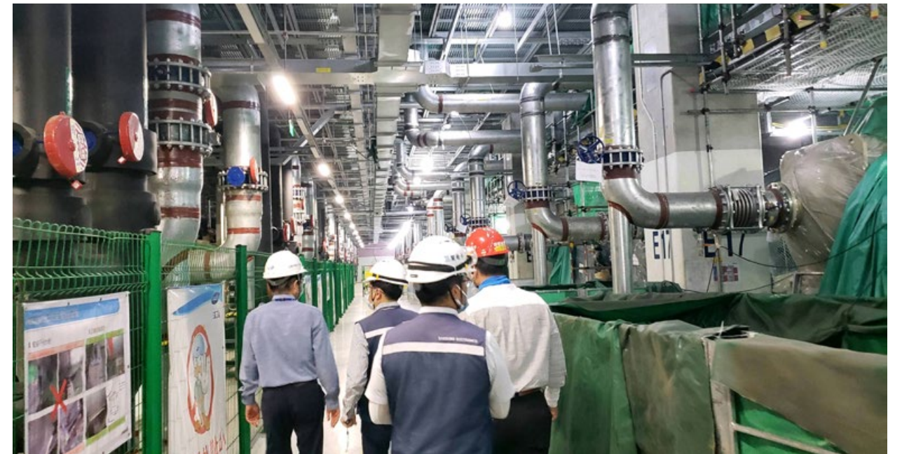
每日现场安全检查
